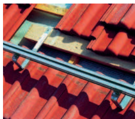
■ Закрепване на колектора с покривна кука и монтажна шина
