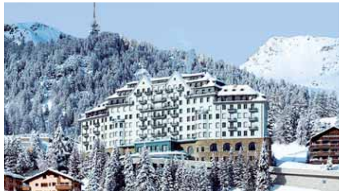
Im 5-Sterne-Hotel Ritz Carlton in St. Moritz wird das Abwasser zur Wärmegewinnung genutzt.
