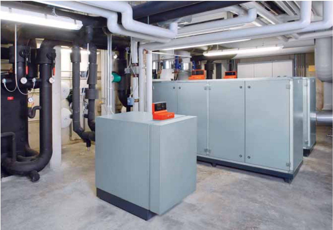
Sole/Wasser-Wärmepumpen Vitocal 300-G PRO und Vitocal 300-G
