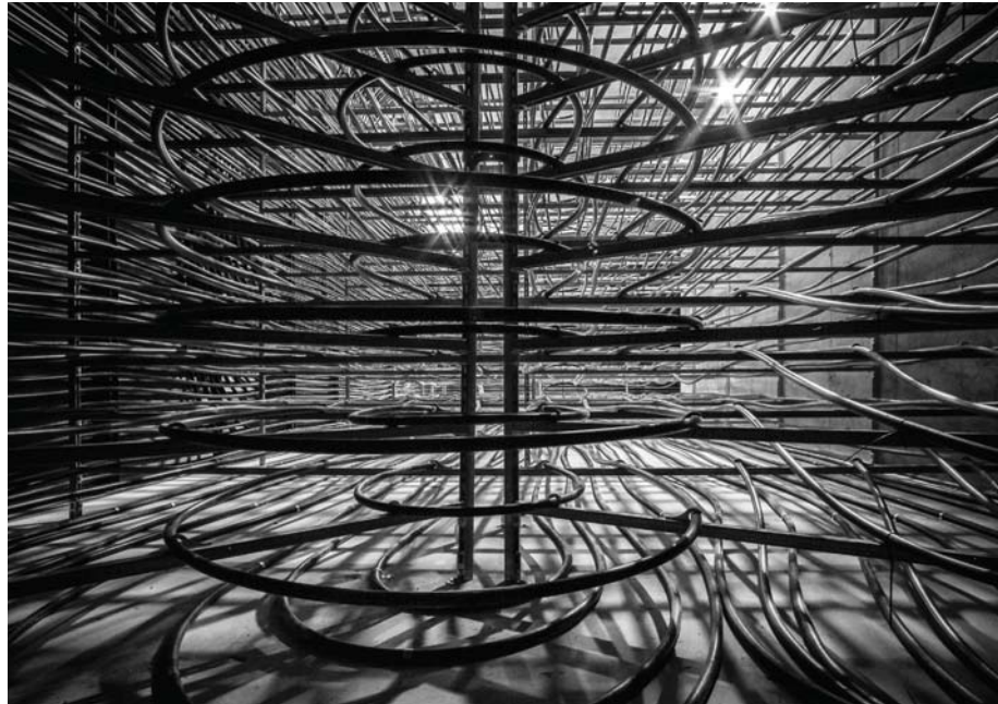
Das Wärmetauschersystem sorgt für kontrolliertes Einfrieren
